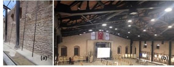
Şekil 5. Çelik kolon-betonarme döşeme bağlantısı yapım aşaması (a) (Meram Belediyesi Arşivi), Çelik taşıyıcı strüktür (b) (Bülbül Bahtiyar, 2019).
