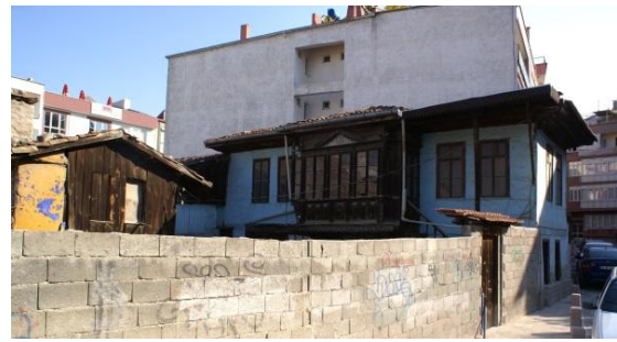
Şekil 5. Altıntop Mahallesi'nde Mavi Ev (Kaynak: Avşar, 2014)
