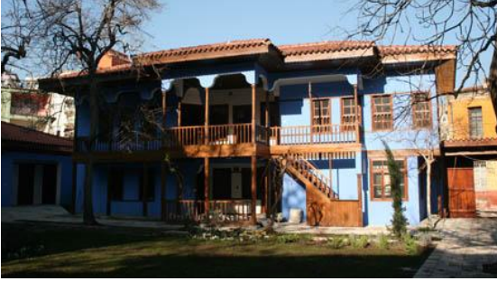
Şekil 4. Şekil 4: Altıntop Mahallesi'nde Mavi Ev (Kaynak: Avşar, 2014)
