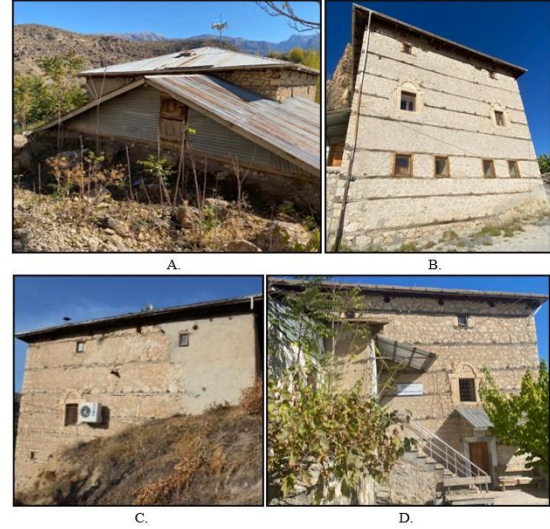
Şekil 16. Mektepönü Cami: A. Kuzey Cephe, B. Güney Cephe, C. Doğu Cephe, D. Batı Cephe
