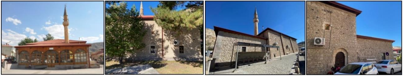
Şekil 3. Gülabibey Cami: A. Kuzey Cephe, B. Güney Cephe, C. Doğu Cephe, D. Batı Cephe
