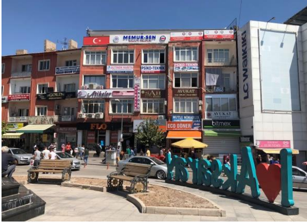
Şekil 9. Mutlu apartmanı doğu cephesi
