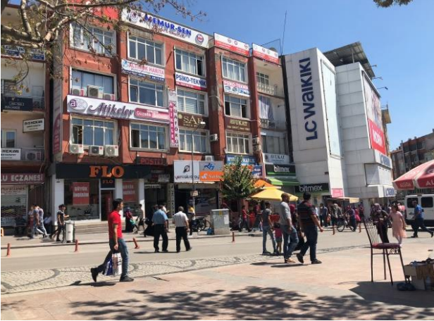
Şekil 13. Mutlu apartmanı cadde görünüşü
