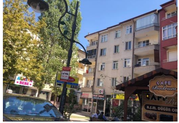
Şekil 23. Cömert apartmanı cadde görünüşü
