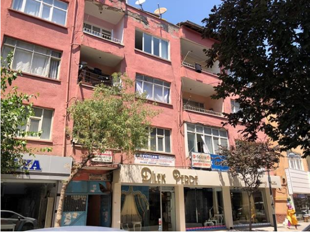
Şekil 15. Tekgül apartmanı güney cephesi
