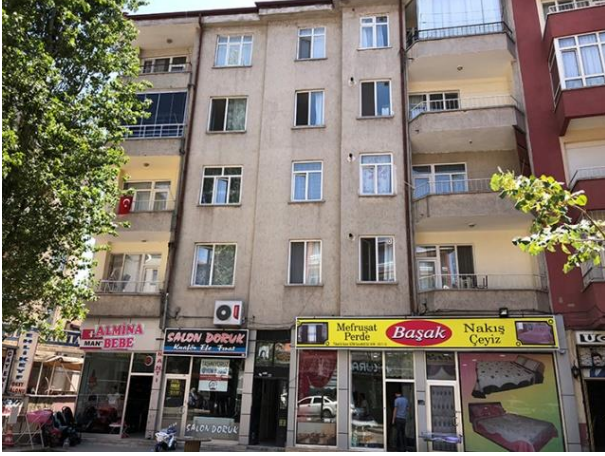
Şekil 21. Cömert apartmanı güney batı cephesi
