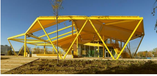
Şekil 16. Ecopolis Kindergarten, gün ışığı kontrolü sağlayan yapı kabuğu
