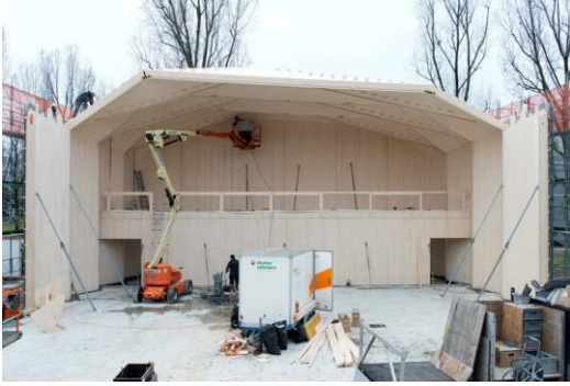
Şekil 31. Vidy Tiyatrosu Pavyonu yapım aşaması (URL 10).
