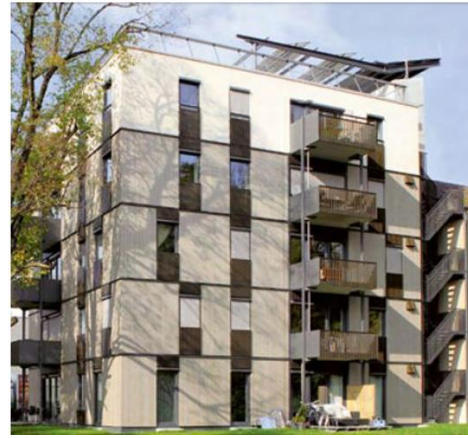
Şekil 16. Bad Aibling’de betonarme – ahşap hibrit bina cephesi (Deutschland, tarih yok)
