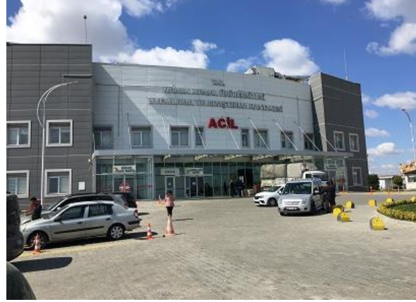
Şekil 11. Uygulama ve Araştırma Hastanesi girişi
