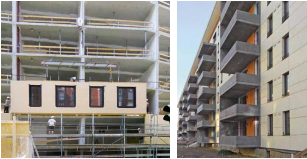
Şekil 18. Frankfurt'ta pilot proje olarak "Aktiv-Stadthaus" cephesi (Deutschland, tarih yok)
