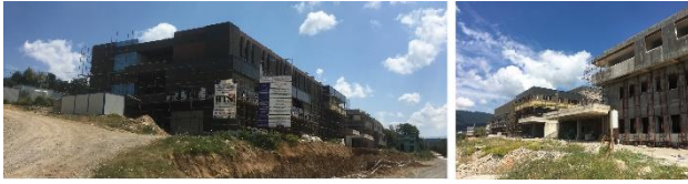
Şekil 13. Bina yapım süreci (24.07.2021)
