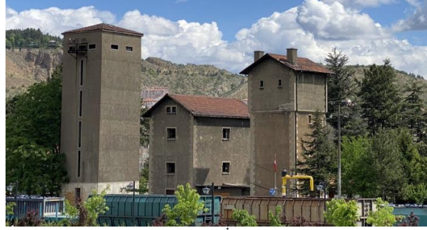
Şekil 4. Çankırı Tren İstasyonu Su Kulesi
