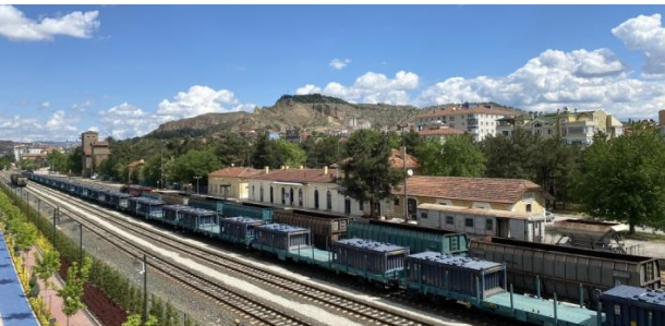
Şekil 3. Çankırı Demiryolu ve Tren Garı binaları
