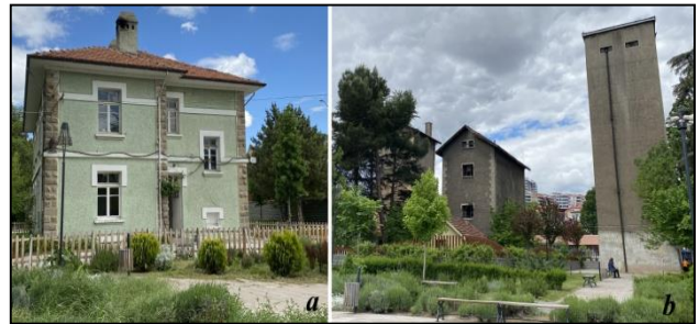
Şekil 14. a. TCDD Yol Bakım Müdürlüğü b. Su Kulesi
