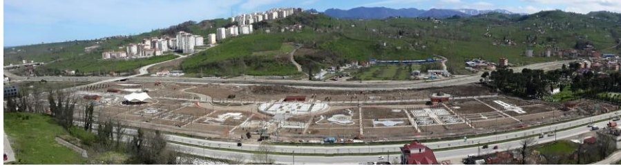
Şekil 10. Proje alanının uygulama sonrası genel görünümü
