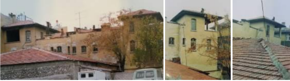
Şekil 3. Yapının güney cephesi (Konya Kültür ve Tabiat Varlıklarını Koruma Kurulu, 1989)
