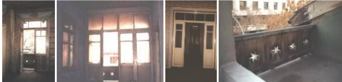
Şekil 11. Birinci kat sofası ve balkona çıkış, balkon korkulukları(2002)
