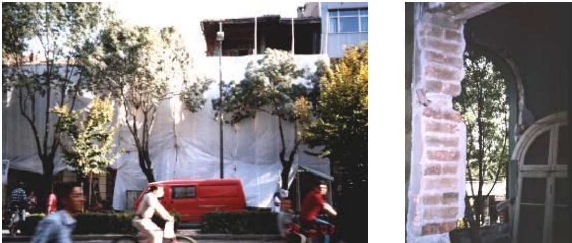
Şekil 15. Yapının yıkım aşamasından görüntüler (2002)
