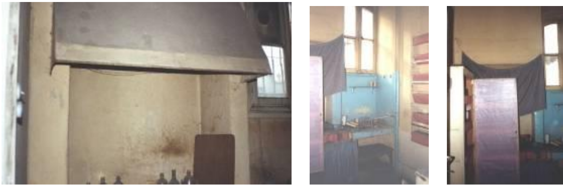
Şekil 12. Mutfak ve ocağın görünüşü (2002)
