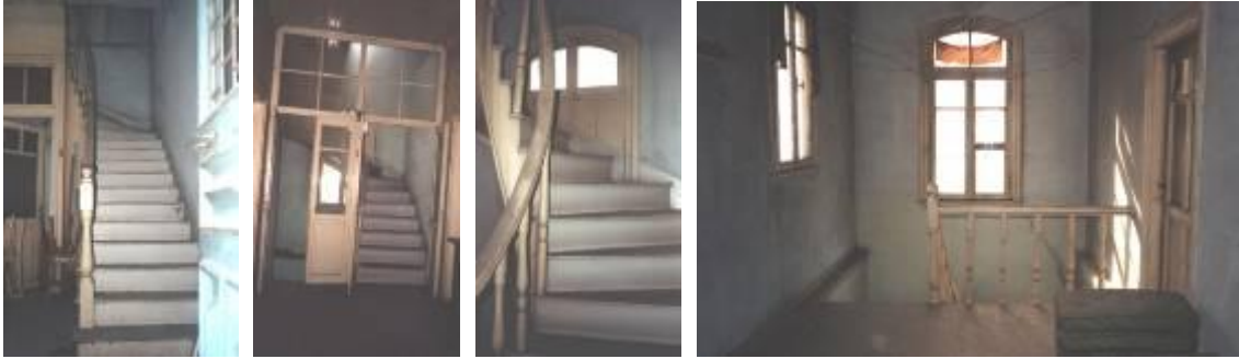
Şekil 10. Yapı İç Mekân Görünümleri - Merdiven (2002)
