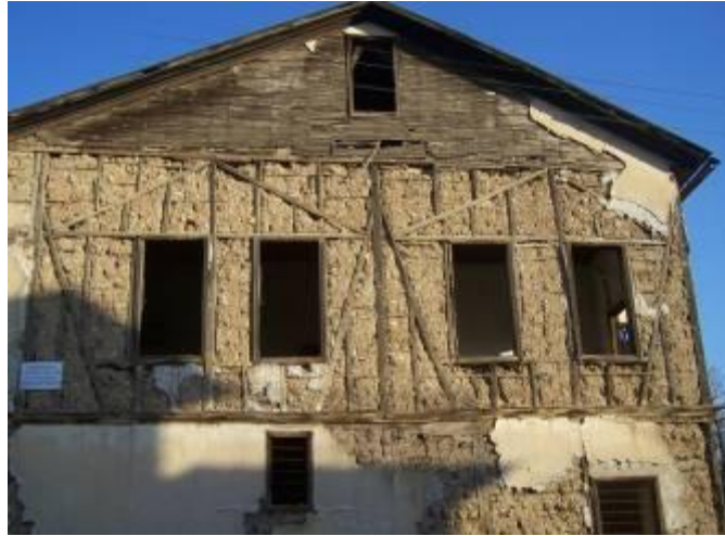
Şekil 20. Ahşap karkas arasına kerpiç dolgu tekniği (Envanter no:180)
