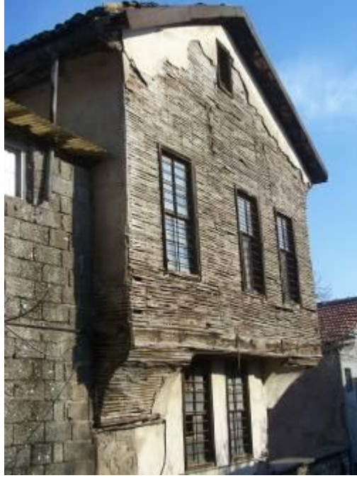
Şekil 21. Ahşap karkas üzeri bağdadi çıta tekniği (Envanter no:29)
