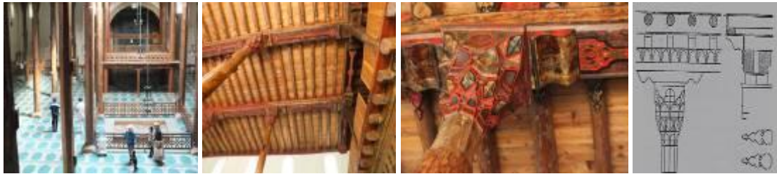
Şekil 13. Sütunlar ve tavan kirişleri (Çizim, Erdemir 1999).
