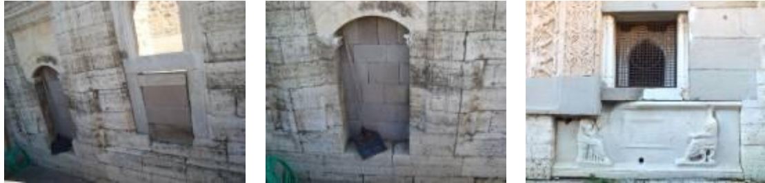
Şekil 5. Taş duvar ile örülerek kapatılan kapı ve roma dönemine ait lahitten sebil görünüşü.
