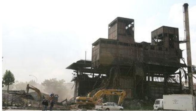
Resim 12. Maltepe Hava Gazı Fabrikası, Ankara.
