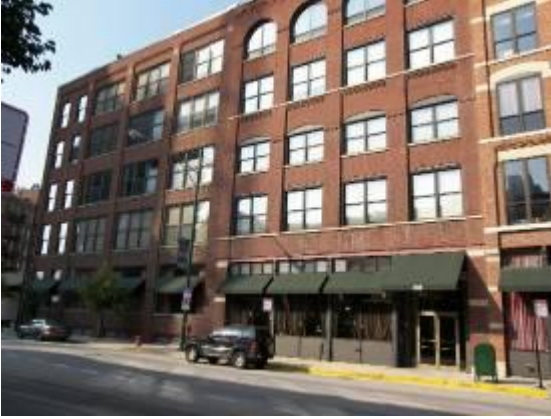
Resim 1. Endüstri Yapısı örneği, 420W Grand Loft, Chicago.
