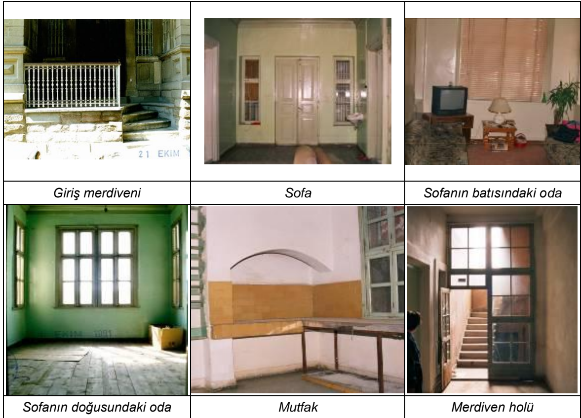
Şekil 4. Yapının zemin kat, iç mekan görünümleri (konut hali)
