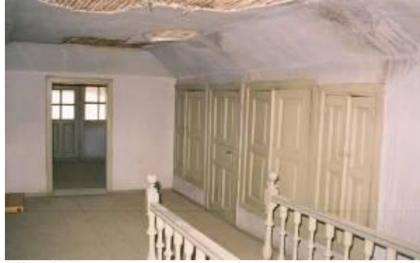
Şekil 8. Yapının çatı kat, iç mekan görünümü (konut hali)
