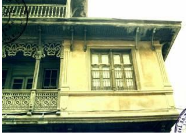
Şekil 10. Çıkma ve saçaklardaki ahşap işçilik
