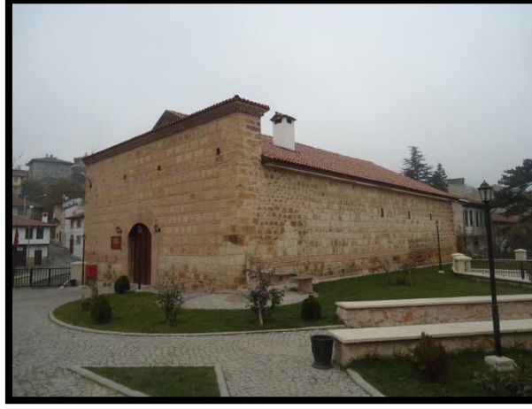
Şekil 4. Restorasyon sonrası Deve Hanı'nın görünümü.
