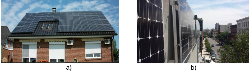
Şekil 5.(a) Çatı üstü ve düşey yüzey, (b) güneş enerji panel sistemi (URL-6, 2016; URL-7, 2016).
