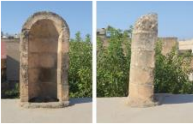
Şekil 12. Şanlıurfa Havalandırma Bacası Örneği (Bekleyen ve Melikoğlu, 2019).
