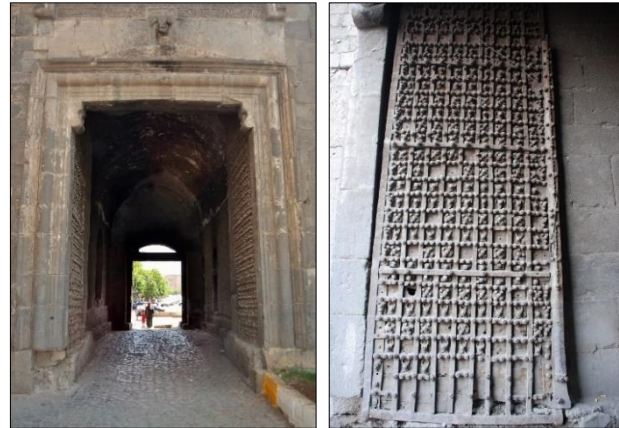
Şekil 6. Urfa Kapı girişi ve demir kapısı
