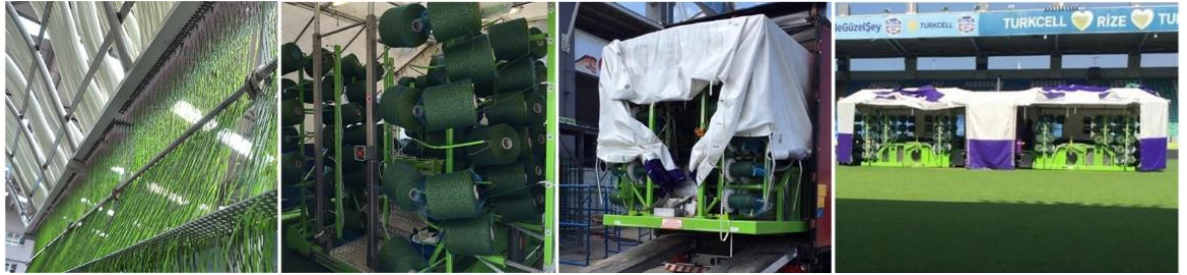
Şekil 4. Trabzon ve Rize statlarında SIS firması tarafından uygulanan hibrit işlemleri
