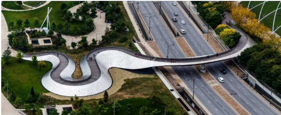
Resim 2. BP Yaya Köprüsü (BP Pedestrian Bridge) (Url 2)
