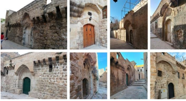
Resim 9. Geleneksel Mardin evlerinde kapı üstlerinde ve teras çatı parapeti hizasında görülen kemer örnekleri (2022)
