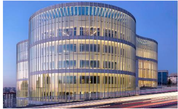
Şekil 4. Vikki Infocenter Korona cephe görünümü ve çift cidarlı cephe (Ark, 1996)
