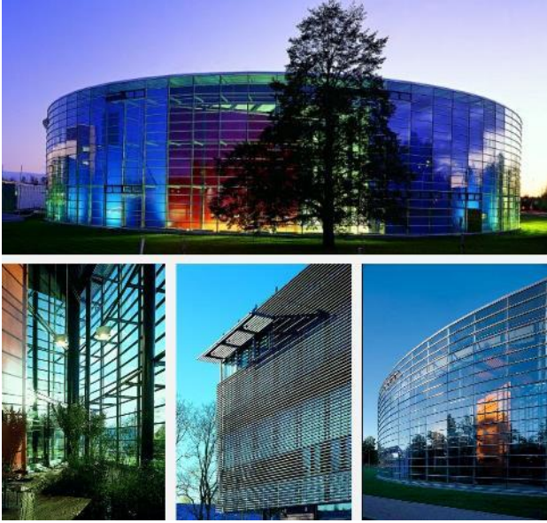
Şekil 4. Vikki Infocenter Korona cephe görünümü ve çift cidarlı cephe (Ark, 1996)
