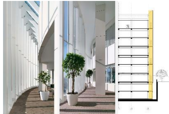
Şekil 6. İstanbul, Küçükçekmece Belediye Binası cephe görünümü ve çift cidarlı cephe (Çilingiroğlu, 2014)
