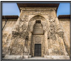
Şekil 6. Divriği Ulu Camii Kuzey Taç Kapısı
