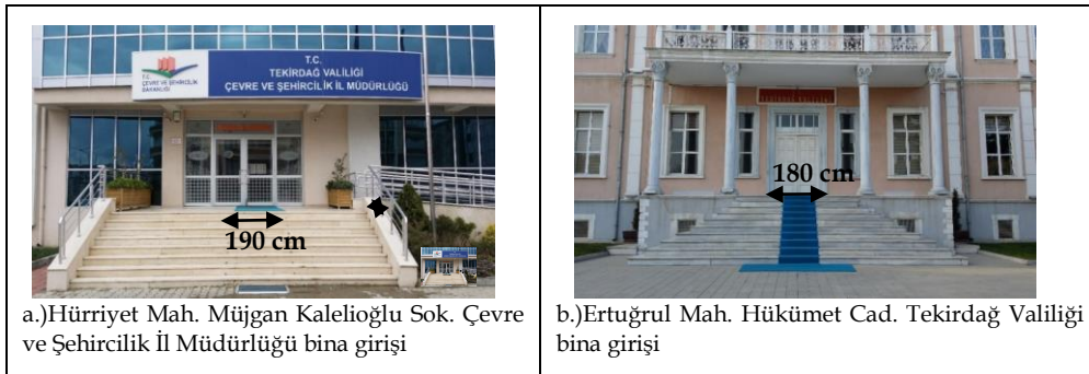
Şekil 8. Çalışma alanına ait bina girişi örnekleri (Orij.)
