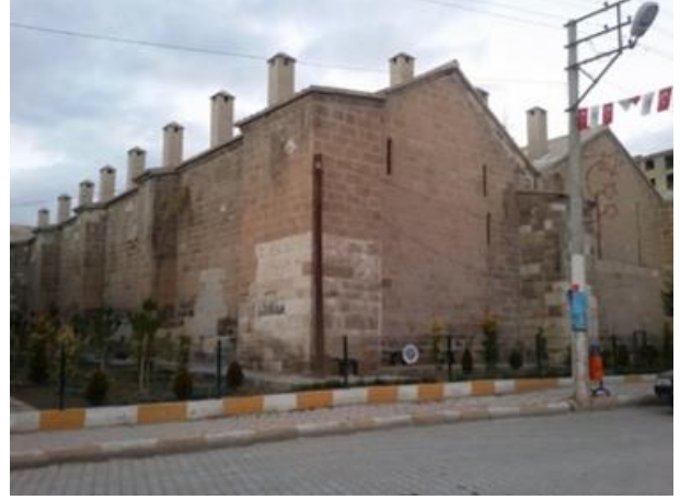
Fotoğraf 9. Öküz Mehmet Paşa Külliyesi, Güney Ahır Batı Cephesi
