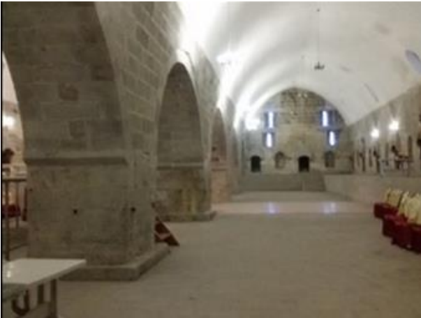
Fotoğraf 7.Öküz Mehmet Paşa Külliyesi, Güney Ahır, Üst örtü beşik tonoz, iki sahını birbirinden ayıran kemerler ve payeler
