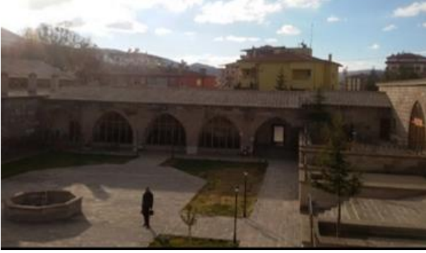
Fotoğraf 6. Öküz Mehmet Paşa Külliyesi, Avlunun Batı Revakı ve Üst Örtüsü
