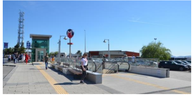
Şekil 4. Kartal Metro İstasyonu 4 no.lu giriş
