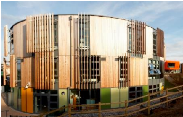
Şekil 14. Rednock School, günüşiği kontrolü sağlayan panjur sistemi ( https://www.levolux.com/tag/rednock-school/ , 2019)
