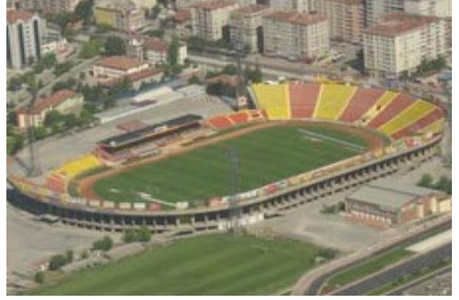
Resim 1. Kayseri Atatürk Stadyumu (yıkılmadan önce)
