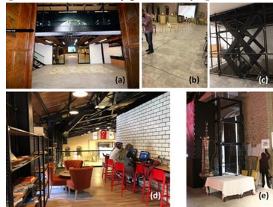
Şekil 9. Protokol (Güney) girişi iç kapı ve iç bölme duvar uygulaması (a) (Meram Belediyesi Arşivi), Hareketli platform (b) (Erdaş, 2019), Platform hareket mekanizması (c), Kitap kafe iç bölme duvar (d), Misafir (Kuzey) girişi cam rüzgârlık (e) (Meram Belediyesi Arşivi).
