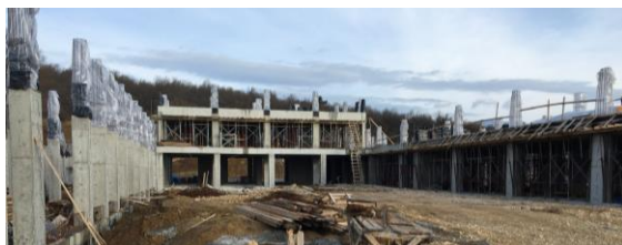
Şekil 7. Cephe ve kütle görselleri ve bina yapım süreci (03.02.2020)
