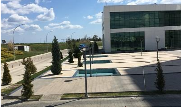
Şekil 3. Sert zemin ve süs havuzları
