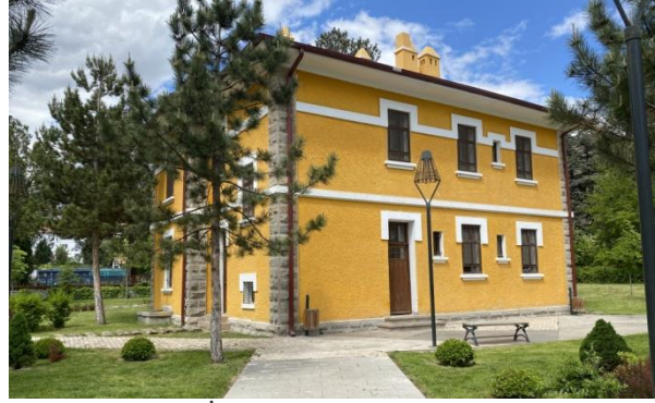
Şekil 5. İstiklal Yolu Parkı Müze Binası
