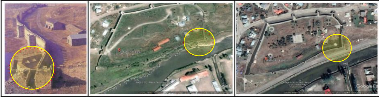
Şekil 7. Ardahan Kalesi Güneydoğu Burcu Kismen Çökmüş Durumu (solda) (URL 1'den işlenerek, 2020), 2006'da Var Olan (ortada) ve 2021'de Yok Olan Burcun (sağda) Hava Fotoğrafları
