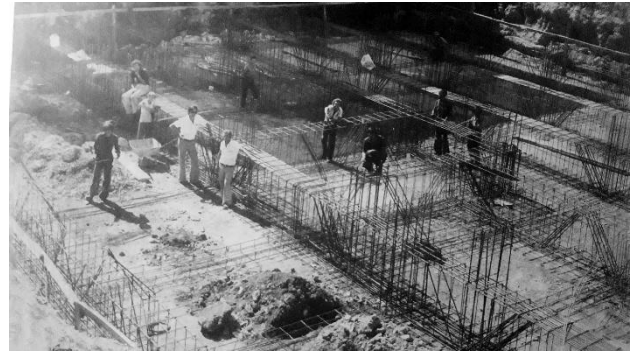
Şekil 12. Ağustos 1975’de Gözde apartmanının temelleri atılırken (Kaynak: Mimarın Kişisel Arşivi).
