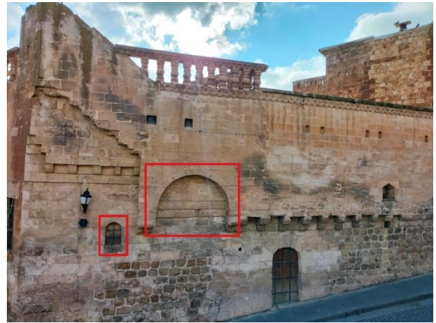
Resim 8. Şeymus Gözüoğlu Evi, kuzey cephe (2022)
