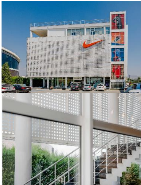
Şekil 5. Nike Avm ve spor merkezi cephe görünümü ve çift cidarlı cephe (Sertoğlu, 2007)
